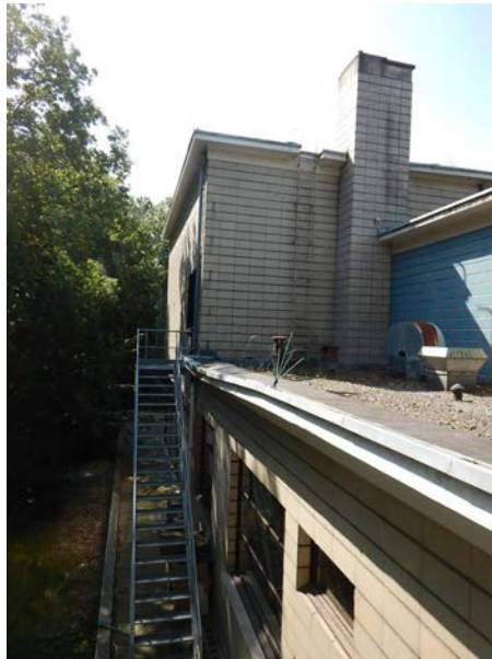
Dak [3]-oost: bochtig verloop dak.
