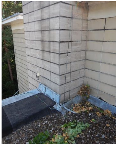
Vleugel [2]: plantengroei in aansluiting met vleugel [1].
