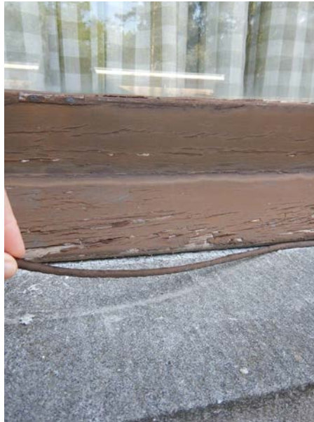
Vleugel [2]-west: de kitaansluiting lost.
