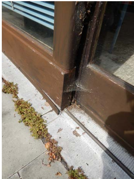
Vleugel [1]: gebreken schuifdeuren.
