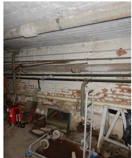
Hechtgebonden asbest toepassing.
