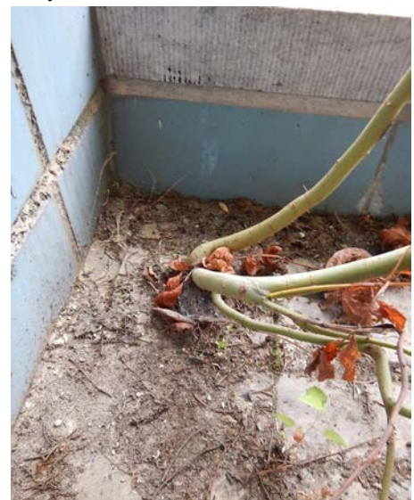
Balkon vleugel [1]-noord: plantengroei in vloertegels onder lekke afvoer.
