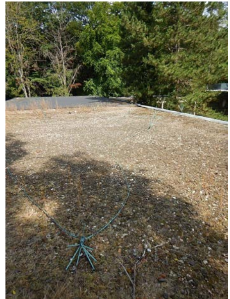
Bliksembeveiliging ligt los op de platte daken.
