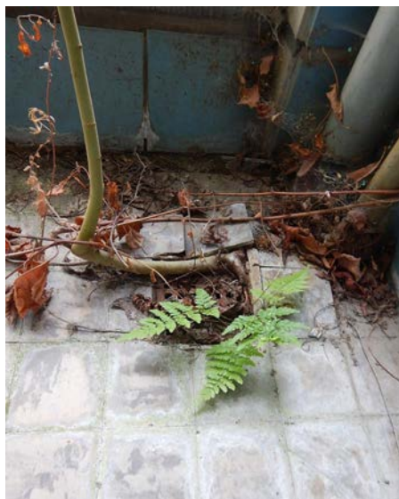
Balkon vleugel [1]-noord: plantengroei in vloertegels t.h.v. tapgat.
