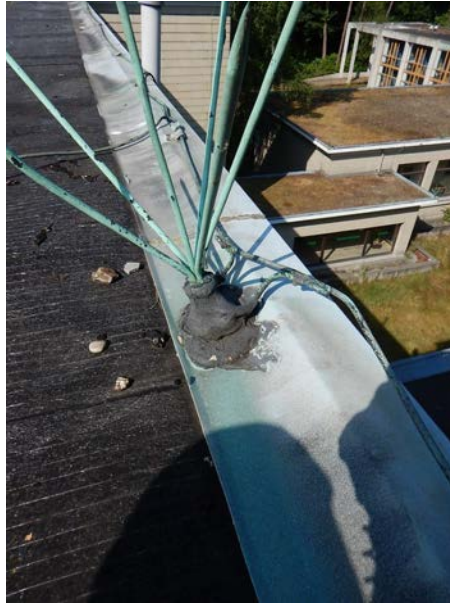
Bliksemtorrs met siliconen bevestigd op zinken dakrand.
