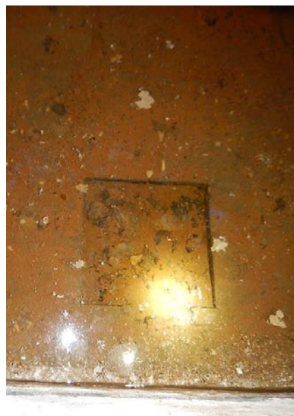
Plaats voor dompelpomp.
