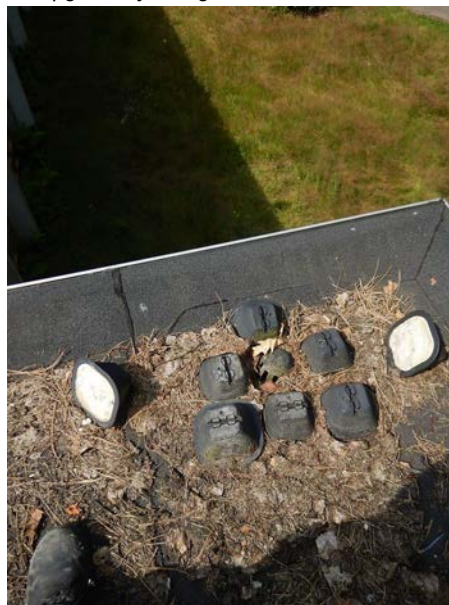
De tapgaten zijn aangeladen met bladafval en delen van de bliksembeveiliging.
