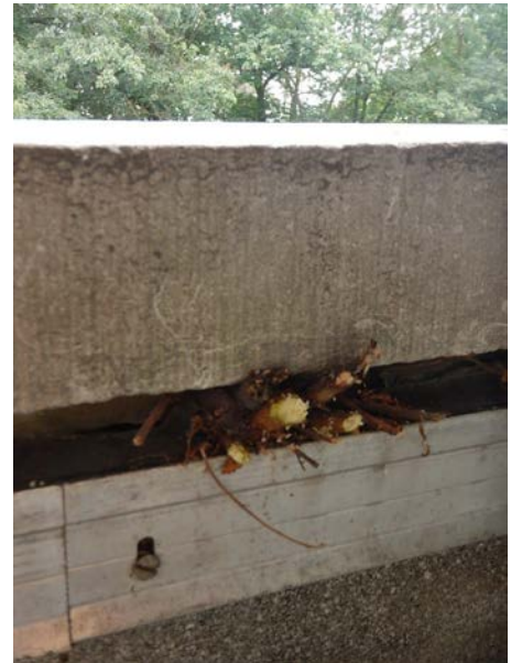
Terras vleugel [1]-zuid: plantengroei in aansluiting verwijderd door Mowa.
