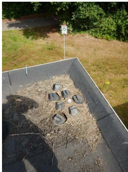
De tapgaten zijn aangeladen met bladafval.
