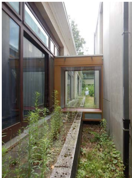
Onkruid in bestrating rond gebouw.
