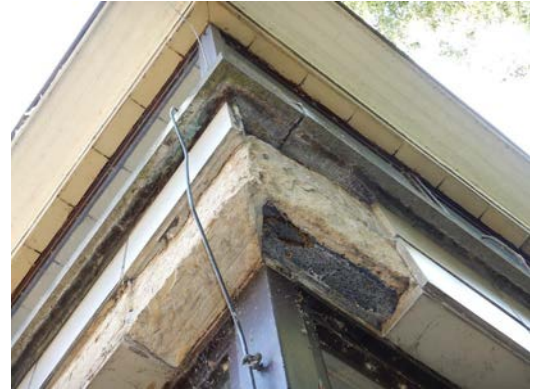
Vleugel [1]-noord: opbouw muurwerk achter tegelbekleding.
