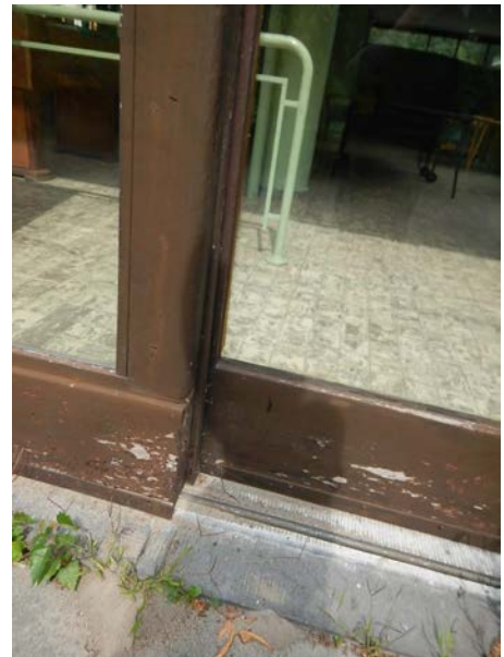
Vleugel [1]: verschaalde verf schuifdeuren.
