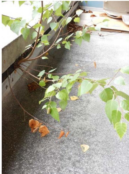
Terras vleugel [1]-zuid: plantengroei in aansluiting.
