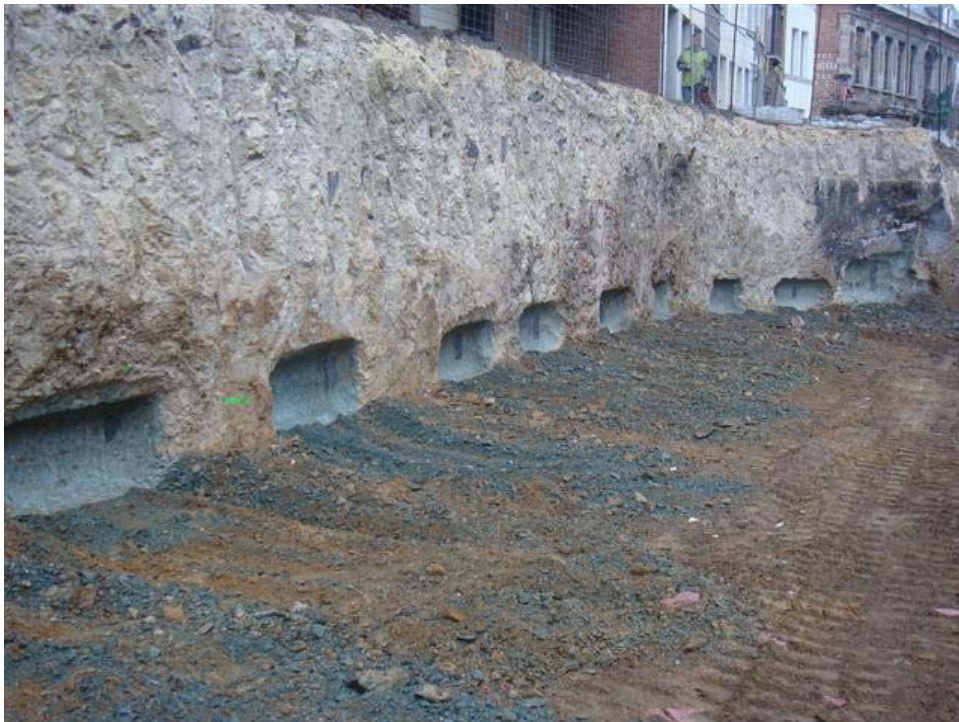
Uitvoering met verzonken ankerprofielen
